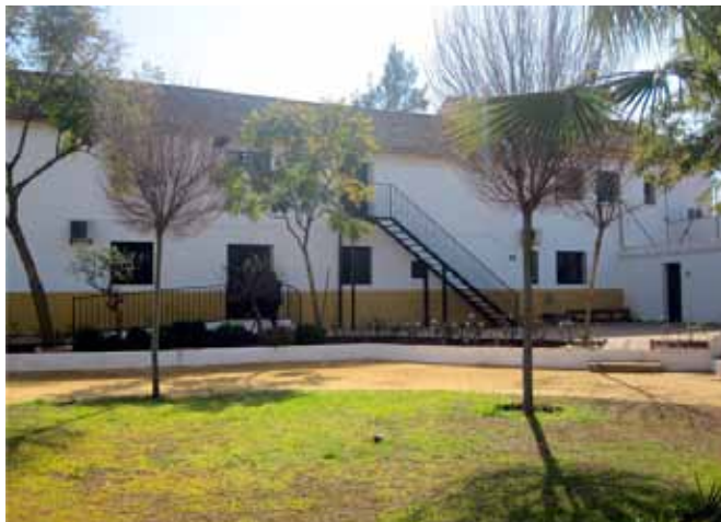
55. Fachada. Centro Cantalgallo.
