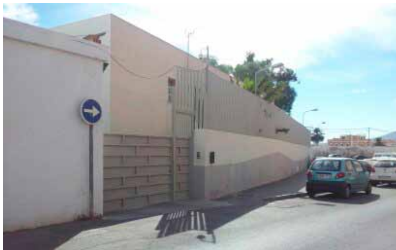
11. Exterior edificio. Centro El Molino.
