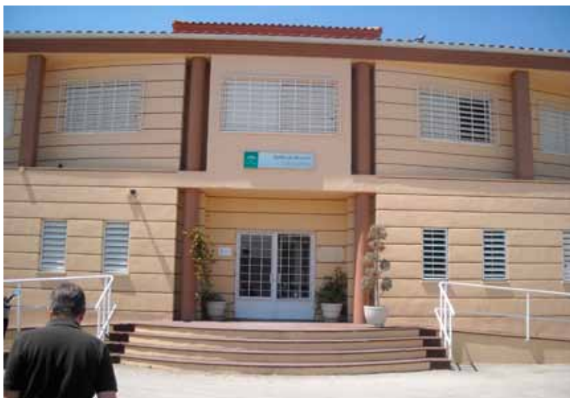
41. Entrada. Centro Las Lagunillas.
