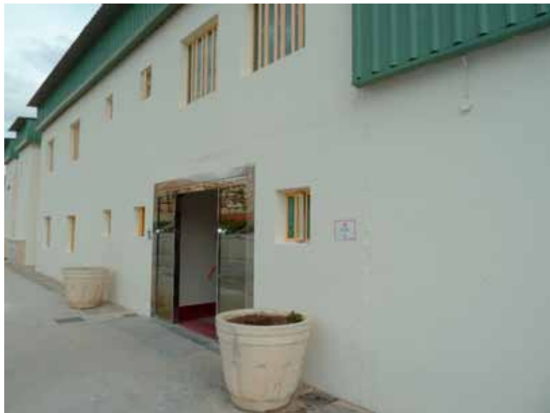
7. Fachada Edificio. Centro Purchena.
