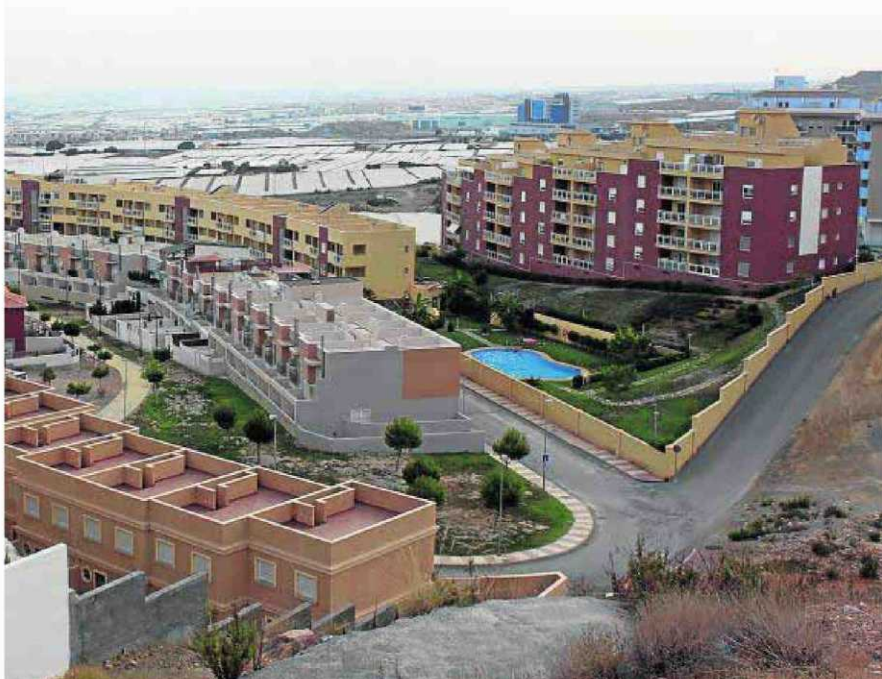
Imagen del barrio de Las Colinas. :: VALDIVIA
