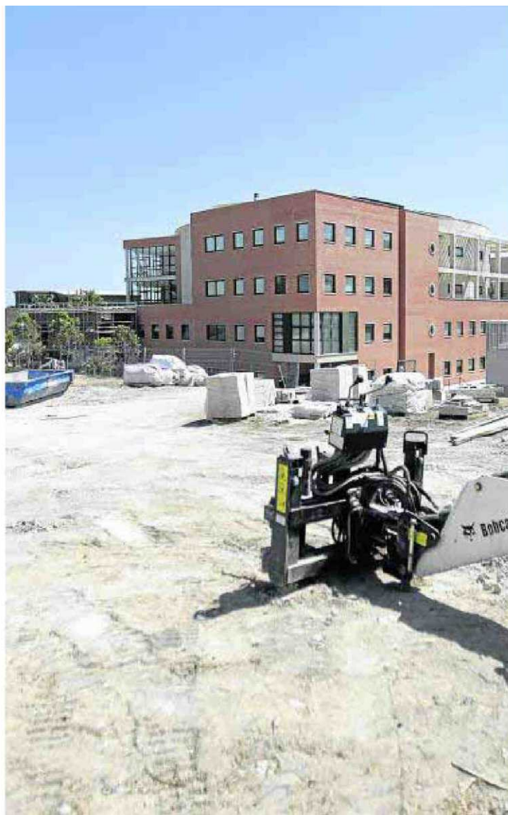
Obras en el Campus de Las Lagunillas. :: MANUEL BÉJAR
