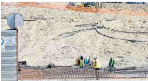
Obreros trabajando en el espacio que ocupará el materno infantil.
